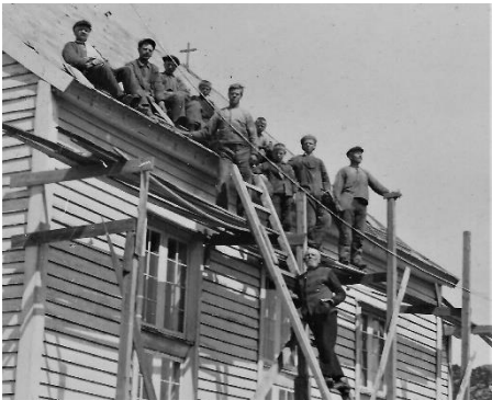
60 – 2. Personer på taket f. v.: Ole Andreas fra Bjerkreim, Sven H. Egeland, ukjent, Torkel Ivesdal rett opp fra stigen, Svein P. Eikeland og Halvard Egeland. Mannen i stegen er Tollef Ivesdal (Gamle Tollei). Arbeid med å legge skifer på taket, Ivesdal kapell 1921. Foto?
