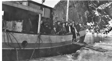
10. Ørsdølen ved iskanten.
