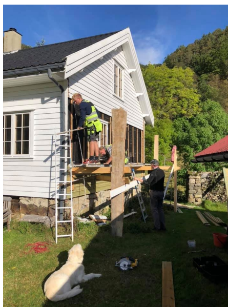
Ny ytterkledning på Huset.
