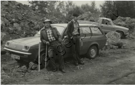
Arne og Tønnes Garheim under bygging av Lauperaksvegen ca. 1980.
