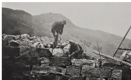
Sverre Svella t.v. og faren Elling i arbeid med låvebrua til den nye Løa bygd i 1946
