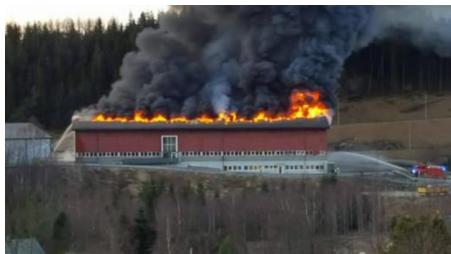
Bjerkreimshallen brann ned 24. februar 2017.
