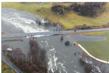
Bjerkreimsbrua over E39.
