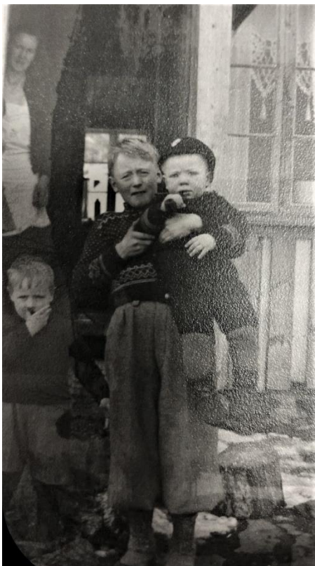
Koselig bilde utfor gamlahuset på Solberg. Retsina står bak, Ingvar står ved sida av Ivar, som bære Leif. Fine gardin i vinduet som Regina heilt sikkert hadde laga. Ho etterlet seg masse fint håndarbeid.
