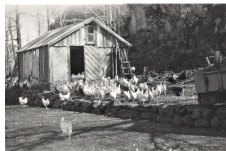
Hønehuset i Skiftingshammeren innpå «røyse» inn forbi dagens bygninger.
