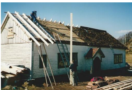
Restaurering av Åsenhuset 2002-2007. Foto: Paul Tengedal.
