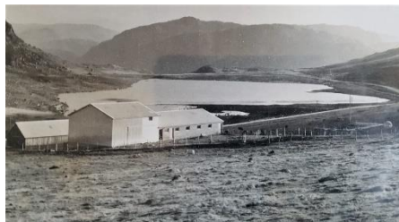
Storrseia ca. 1966. Vi ser at driftsbygningen er oppsatt og husmuren er oppført.
