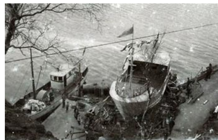
Bygging av Ørsdølen II i Odlandstøet.
