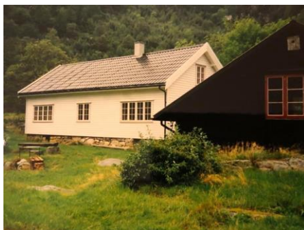
Landsdalshuset og kufjoset utvendig ferdig oppussa sommaren 1993. Foto: Ståle Undheim.
