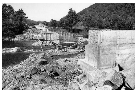
Bjerkreimbrua over elva for den nye E39 ca.1970.
