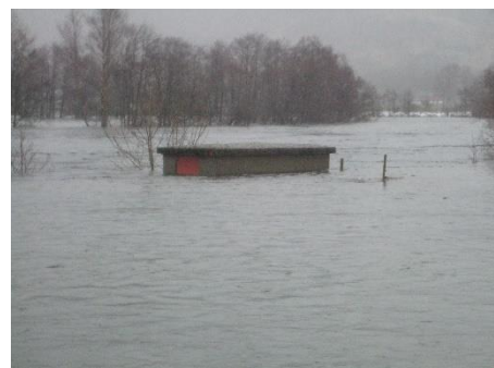
Vannet når like under taket på pumpehuset. Her er avsatt et måle-merke. Alle fire foto: Paul Tengesdal.
