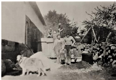
Her støper de den første siloen hos Ragnvald Steinsland i 1946/47.
