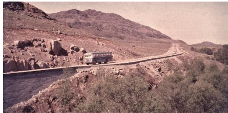
Storrsheibakkane E-18, E-39 Planlegginga begynte 1956 og arbeidet starta opp som nødarbeid etterjulsvinteren 1958, med spade og trillebore i skjæringen overfor Solheim. Ein begynte å kjøra vegen i midten av juli 1961 og offesielt opna i des. 1962, og namnet endra til E-39 27. mai 1997. Mange helsa den nye vegen velkommen, og tenk ein europaveg gjennom Bjerkreim! Her kjører Bilselskapet søndagsrute våren 1962. Myrdraget ned gjennom skogen-kallast Suez. Foto: Per Espedal
