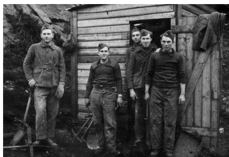
Reier Tengedal t.v. ute i arbeidstjeneste i AT-leiren på Eikeland. Her ved ei anleggsbrakke ute i terrenget. Foto: Jørgen Tengedal
