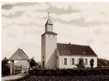
Bjerkreimskirken bygget i 1835.
