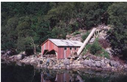
I Dyrskog var det eigen tømmerkog. Her er bilete av den nye saga etter som den gamle saga brann opp. Dette var ei oppgangssag som blei driven av vasskraft.
