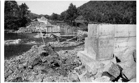
Bjerkreimbrua over Gjedleiva bygget i 1975.
