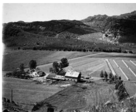
Garden til Knut Bakke i 1962. Utgravningen til den nye driftsbygningen er nettopp påbegynt.
