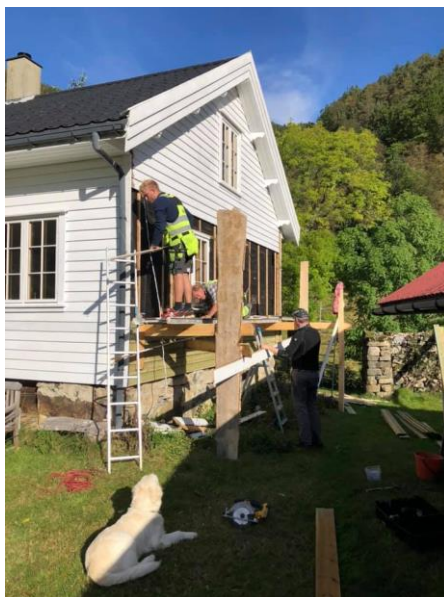
Ny ytterkledning på Huset.
