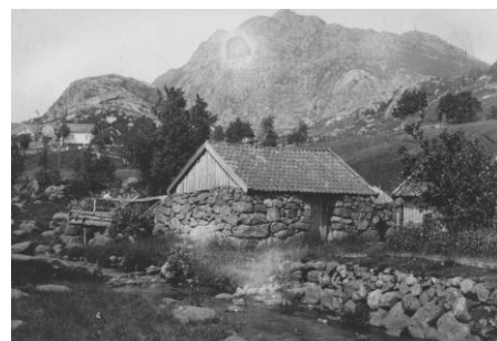
Tørkehuset med vasshjulet på venstre side som drog treskemaskinen på lensmannsgarden. Snora gikk i bein linje forbi lensmannshuset og inn på låven. Under treskinga stengte de vegen for omkjøring forbi Petter-garden.
