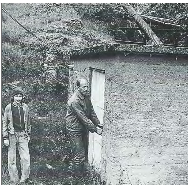
Anstein Hovland og sonen Tor Sigve ved gards-kraftverket i 1975.
