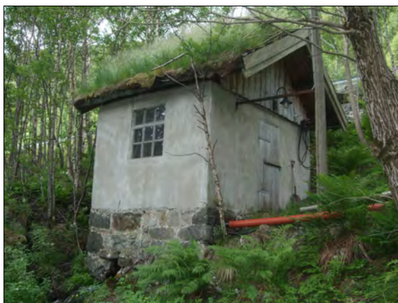
Kraftverket står nedenfor vegen vest for Austrumdal.
