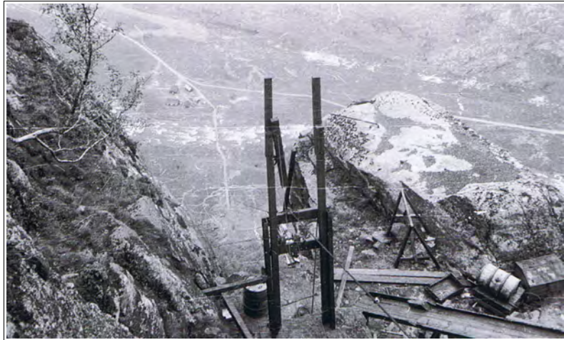
Heisbukk for taubanen til Schaannings gruve. Foto: Ukjent.
