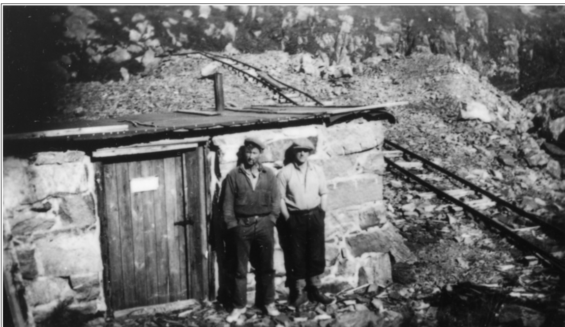
To av gruvearbeiderne på heia i 1940-åra. T.v.: Tomas Vassbø og Jørgen Hovland står utenfor den første anleggsbrakka (4) rett under fjellet Gudlen. Tomas, Jørgen og Tollef Kvitli/Hovland, far til Jørgen, var de første utpå 30-tallet som arbeidet nettopp i dette området. De lå alle i denne hytta da.
