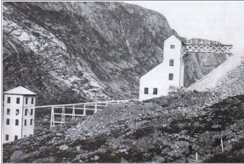
Oppredningsanlegget for det britiske selskapet. Knuseverk til høyre, med tilførselsrampe fra stollinngangen, og Elmorevaskeriet i det høye huset nedenfor. Foto: I. Melhus.
