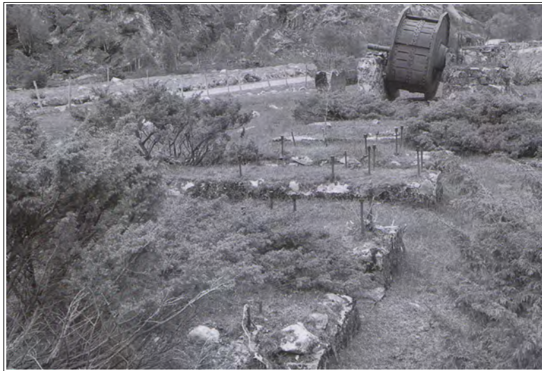
Rester av Ørsdalselskapets oppredningsverk med Humbolt-kulemølle og fundamenter for flotasjonsverket. Foto: Frode Sæland.
