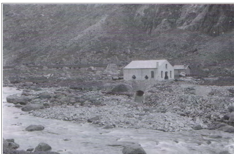
Den første kraftstasjonen fra 1905 med tilførselsrenne i tre fra Storåa. Foto: E.H. Torjusen.
