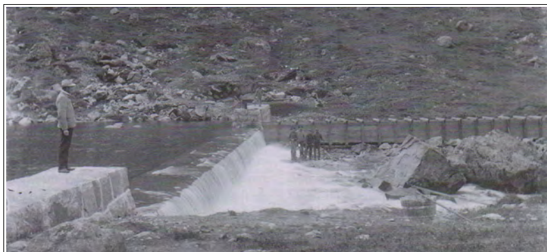
Damanlegget ved Storåa i forbindelse med den første kraftstasjonen. Foto: E.H. Torjusen.
