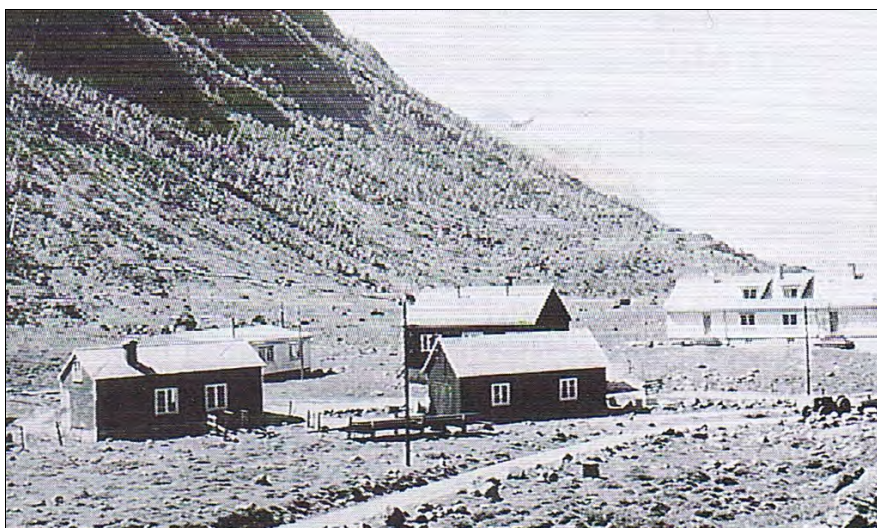
Det tyskkontrollerte selskapet Det norske Bergkompani A/S i Oslo stod for gruvedrifta under andre verdenskrig og bygde flere bygninger nede i dalen da, mellom annet nytt kraftverk, malmvaskeri, knuseri og flere anleggsbrakker og bustader. På dette bildet fra tidlig i 1950-åra ser vi noen av anleggsbrakkene som arbeiderne bodde i, og funksjonærbustad lengst nede i dalen. Denne vart seinere ombygd til gjesteheim i Ørsdalen. Foto: Ukjent.
