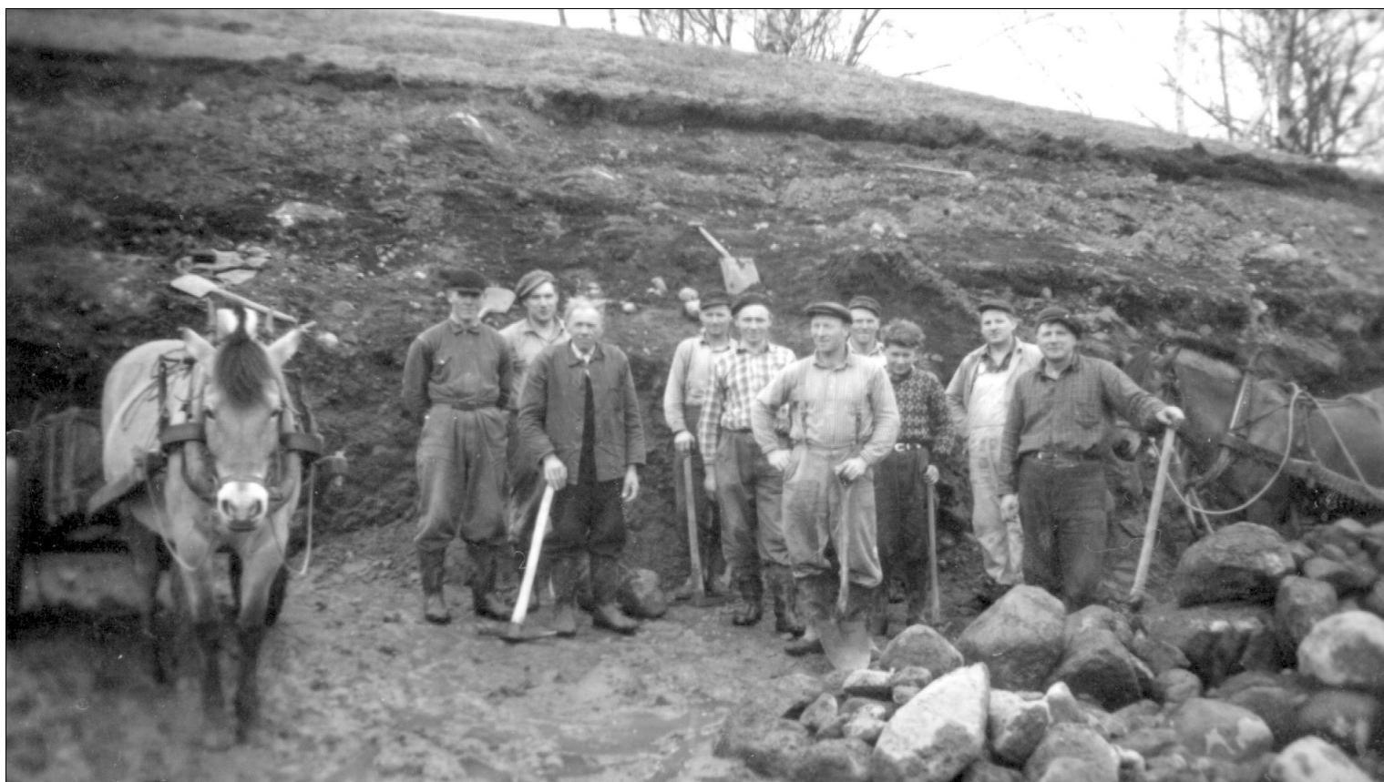
Dugnadsfolk grev ut grunnen til fjaset åt Agerton Asheim i 1951. Det er to hestar med «skrovkjerra». Dei hadde prøvd med bulldoser, men den kom ikkje gjennom aurlhella. Fv.: Sven G. Skjæveland, Agerton Asheim, Erik Ivesdal, Klaus Skjæveland, Trygve Ivesdal, Einar Ivesdal, Tønnes K. Skjæveland, Oddmund Asheim, Georg Asheim og Hans Asheim
