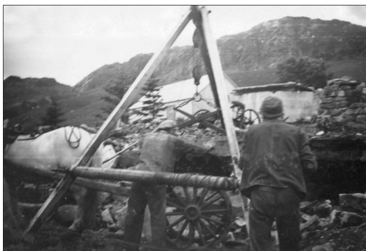
Dei løfter ein kilt stein opp på steinkjerra med steinbukken hjå Eivind Sveta.
