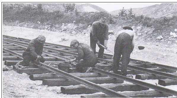
Skinnelegging på Ålgårdsbanen ved Figgjo, 1924.
