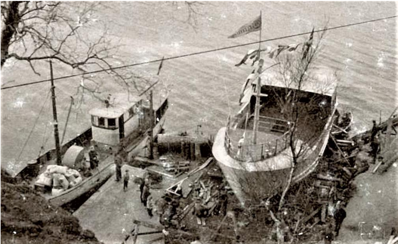
Ørdsølen II ble bygget opp på kaia i Odlandstøet, av seksjoner som kom fra verftet i Flekkefjord.. Foto ukjent.
