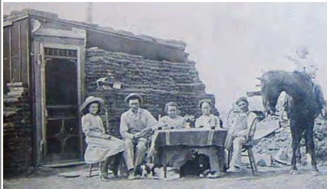
Tjærepapp hytta ble ofte kledd utvendig med gresstov som beskyttelse mot været. Om sommeren kommer temperaturen opp i over +40 °C, og om vinteren ned til under - 40 °C. Da ble hytta lun om vinteren selv i bitende snøstorm, og sval om sommeren selv i stekende solskinn.
