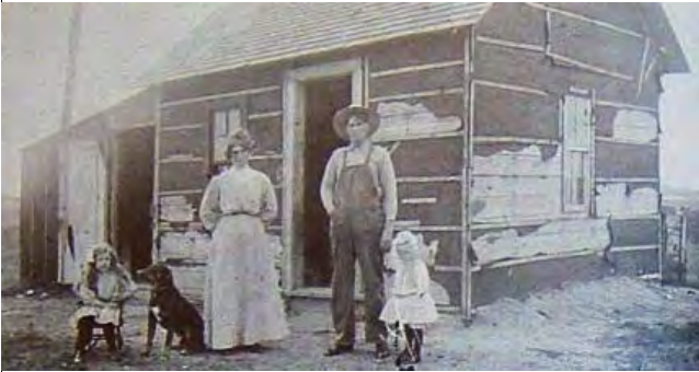
En typisk tjærepapp hytte, såkalt «tarpaper shack». Her bodde familien den første tiden før de fikk satt opp mer varige hus og driftsbygninger.
