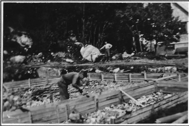
Arbeid med forskalinga i husgrunnen.
